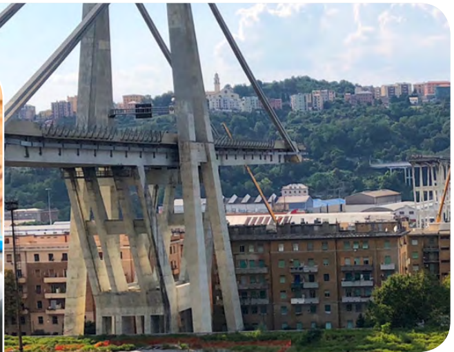
Morandi viaduct © Wikimedia commons / Michèle Ferraris
